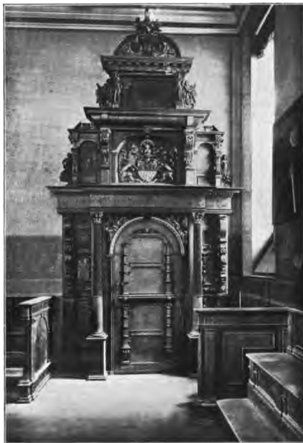
Encadrement de porte de la salle du Sénat à l'Hôtel de Ville (1602).
